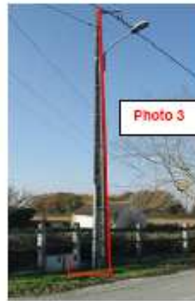
Branchement aéro-souterrain
